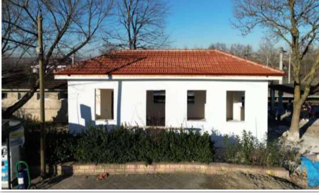
Derbent Mahalle Muhtarlığı Binası Yapımı/Derbent Mahallesi
