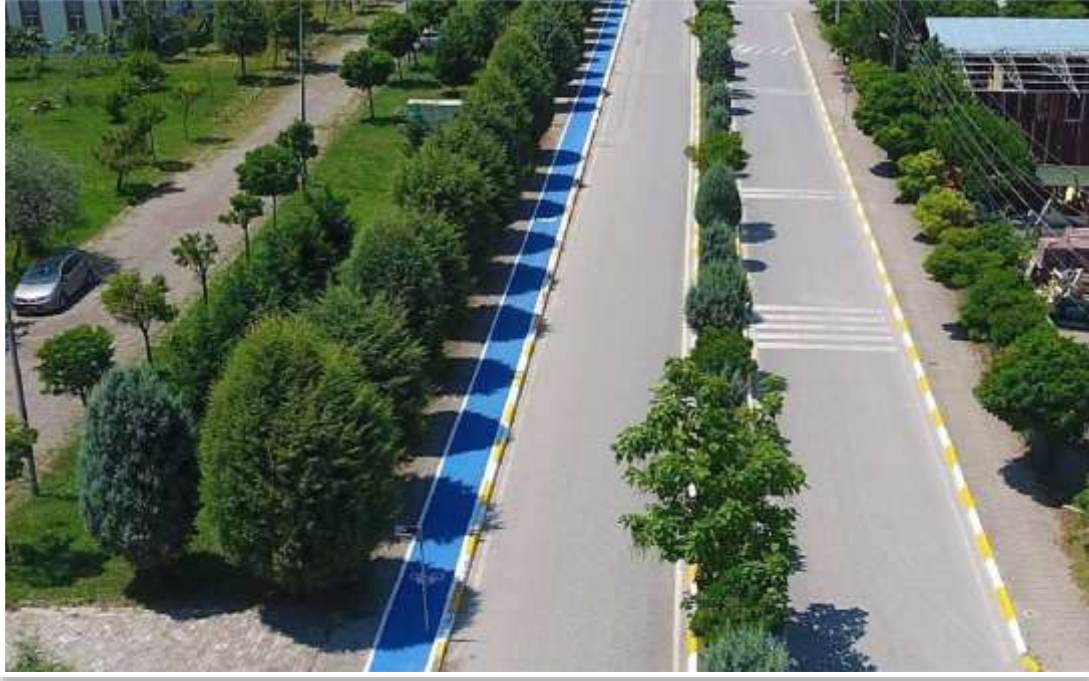
Bisiklet Yolu Yapımı/Balaban Mahallesi-Suadiye Mahallesi
