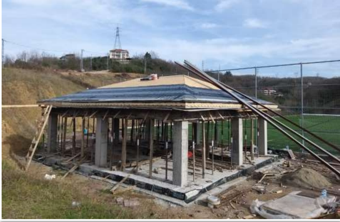
Eşme Futbol Sahası Sosyal Tesis Binası Yapımı/Eşme Mahallesi
