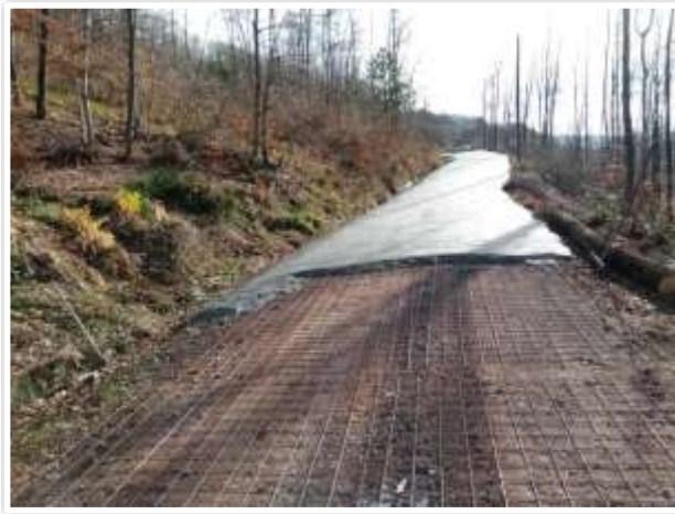
Beton Yol Yapım Çalışmaları
