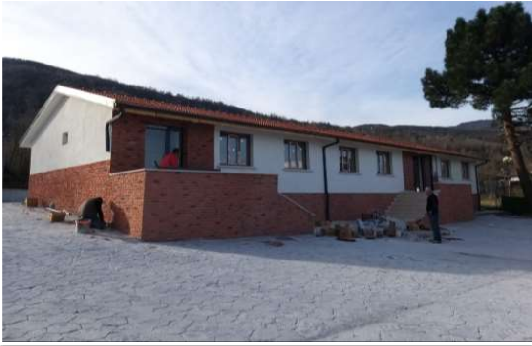
Suadiye Eski Belediye Hizmet Binası Yapımı/Suadiye Mahallesi
