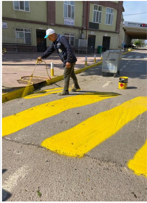
Kaldırım Kenarlarının Boyanması
