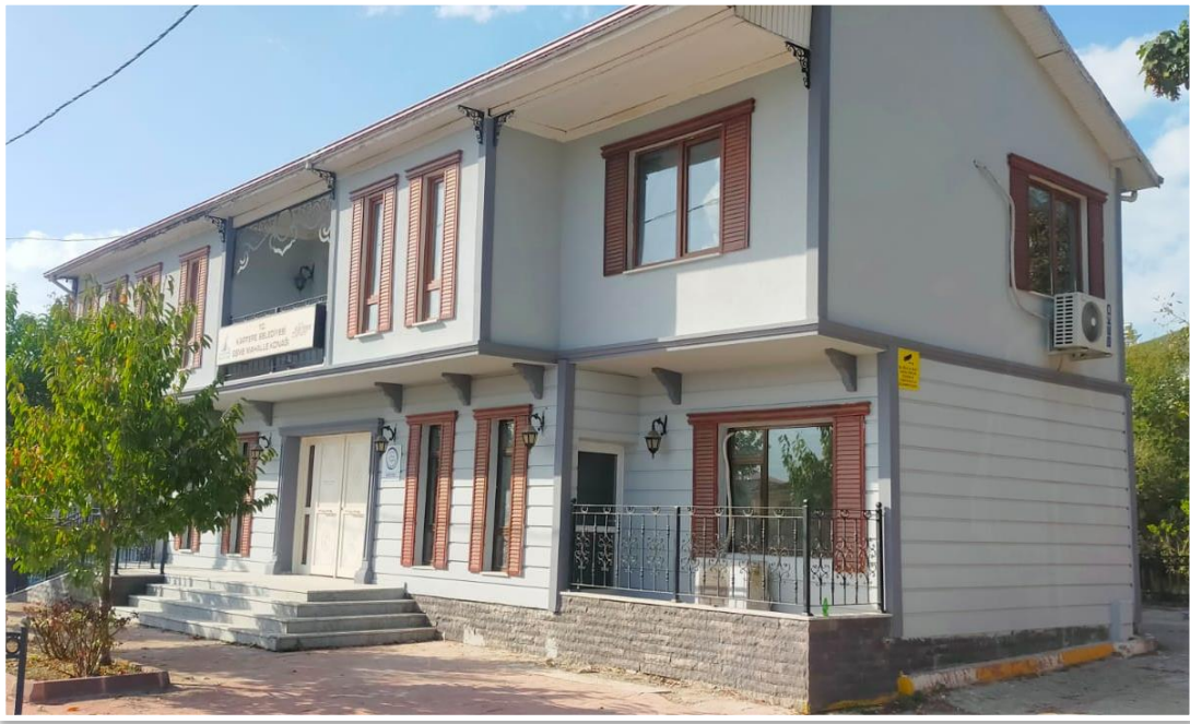
Eşme Mahalle Konağı Tadilatı/Eşme Mahallesi
