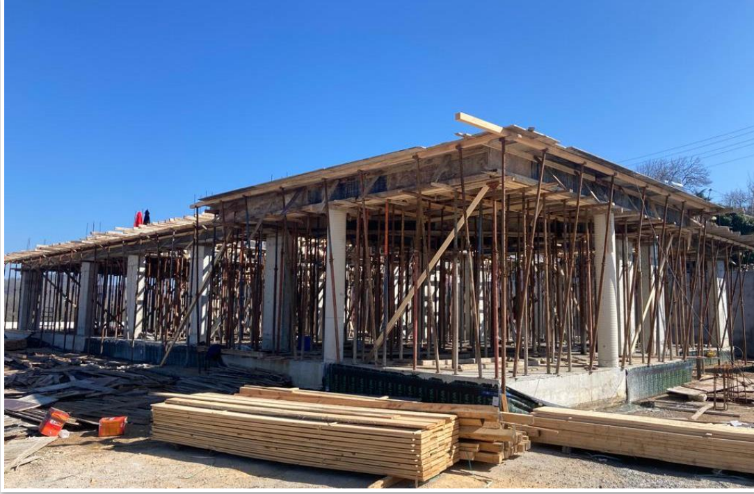
Ketenciler Kültür Merkezi/Ketenciler Mahallesi
