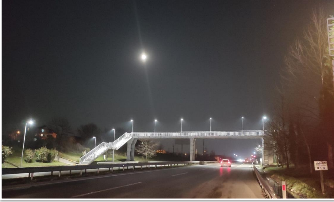
Üst Geçit Aydınlatma Yenileme İşi/İbrikdere Mahallesi
