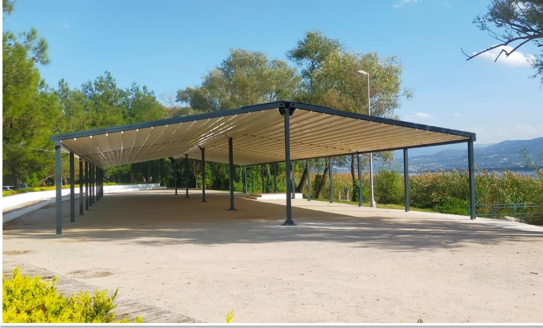
Eşme Sahil Düğün Salonu Tente Yapımı/Eşme Mahallesi
